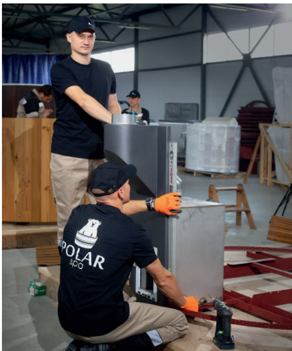
Установка печи на металлокаркас.
